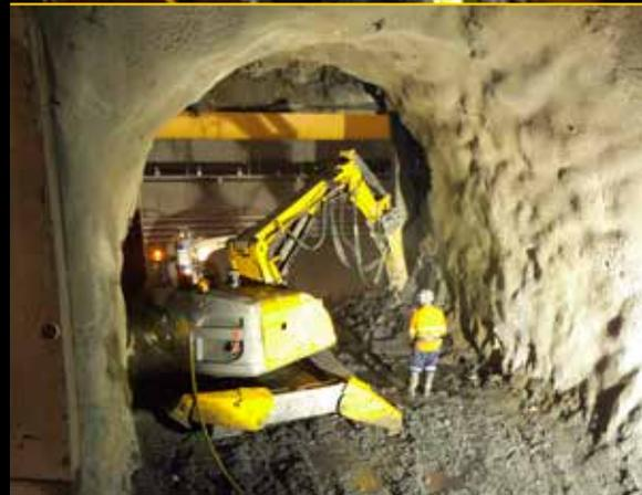
**Brokk 800** équipé d'un MB 1200 travaillant dans une niche de sécurité en Italie.
