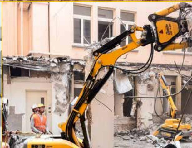
**Brokk 100** équipé d'un TE-160-100, construction de sous-sol.
