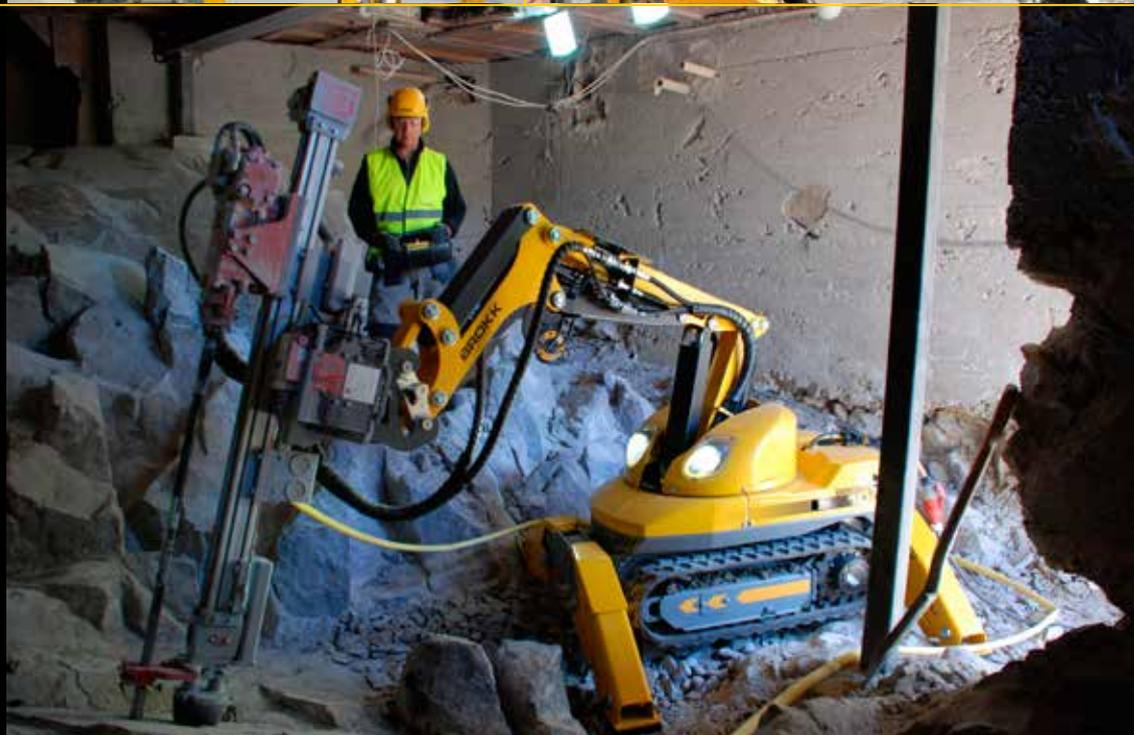
**Brokk 60<sup>u</sup>** équipé d'un CC260 démolition d'un pilier en béton armé.
