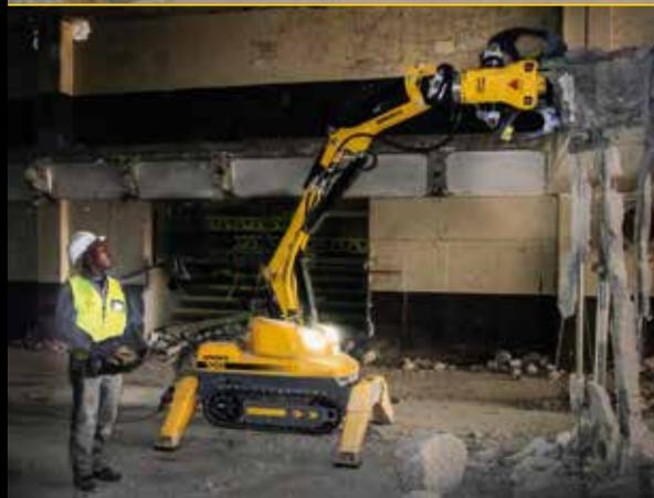
**Brokk 400** avec cisaille à béton CC700 démolissant du béton armé.
