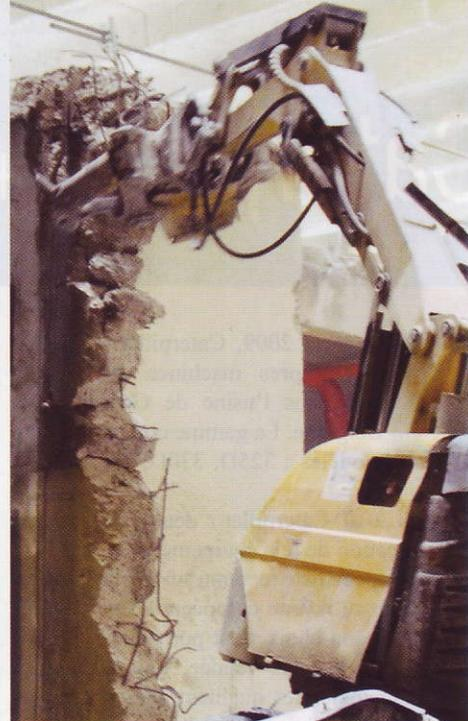
**Brokk 90, 180, 260 :** Un Brokk 180 au travail au brise-roche dans une cage d'escalier
